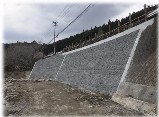
河川の改良工事
